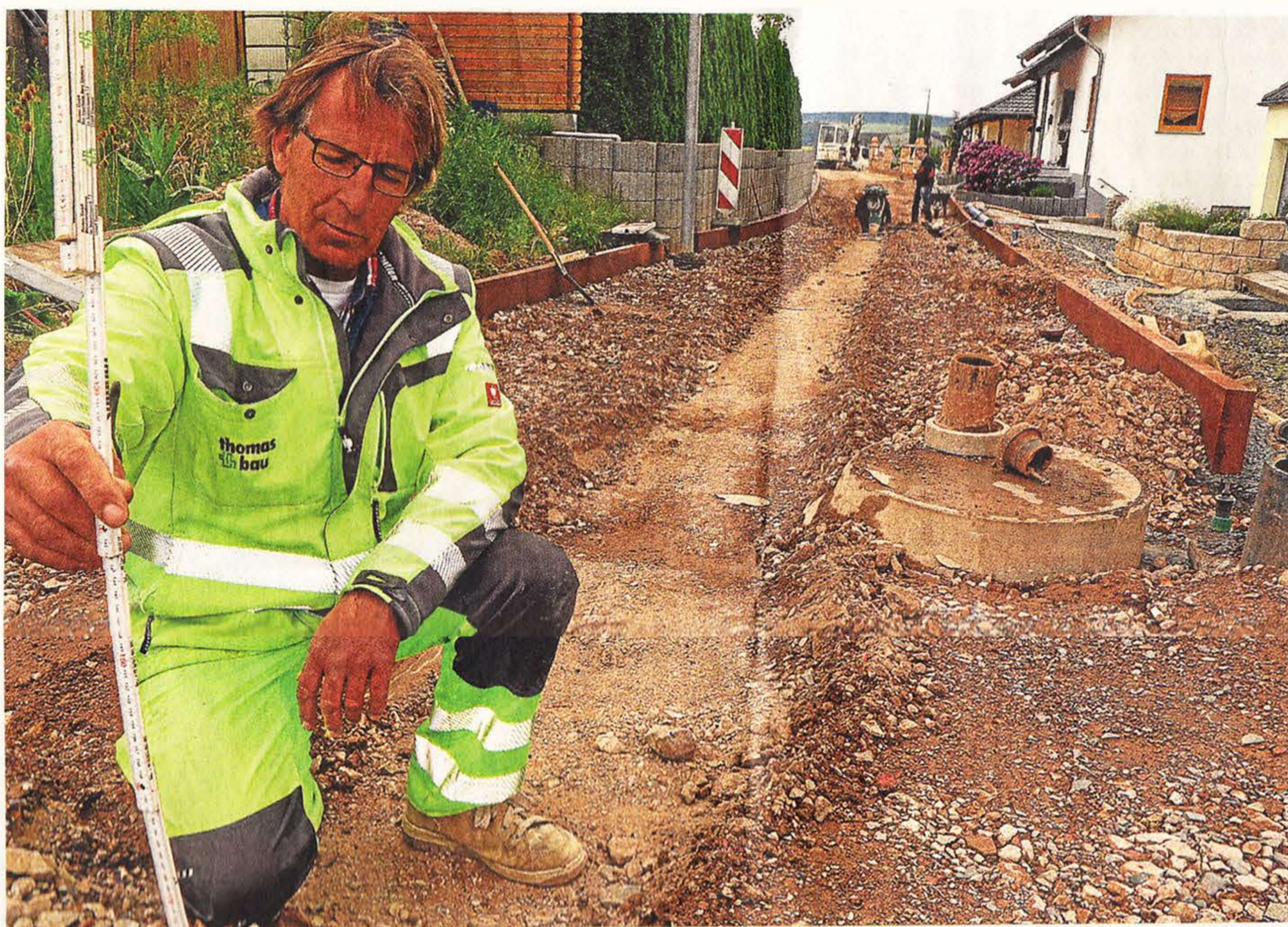
Der Mann vor Ort in Leinenborn 2: Polier Stefan Kochler von Thomas Bau beim Ausmessen in Stichstraße 1 unterhalb des Spielplatzes. Die Kommunikation klappt: „Wir sprechen uns mit den Anwohnern ab.“
