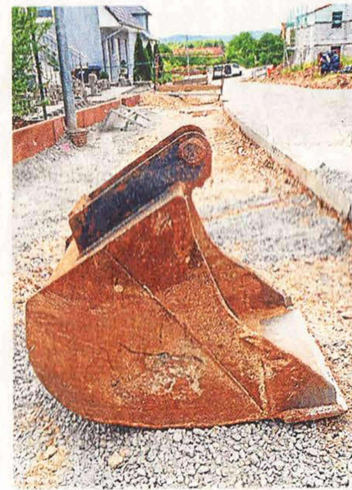
Straßenbaustelle Nummer zwei: Auch sie soll bis 1. Juli fertig sein.
